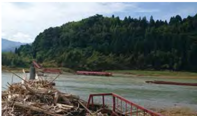
2020年7月球磨川水害 落橋した「球磨川第四橋梁(くま川鉄道)」(提供:角 哲也)
